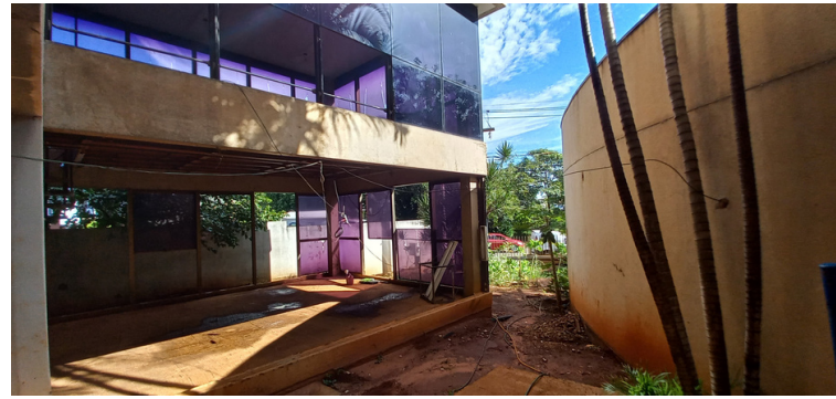
Foto 4 - Parte interna do prédio.
