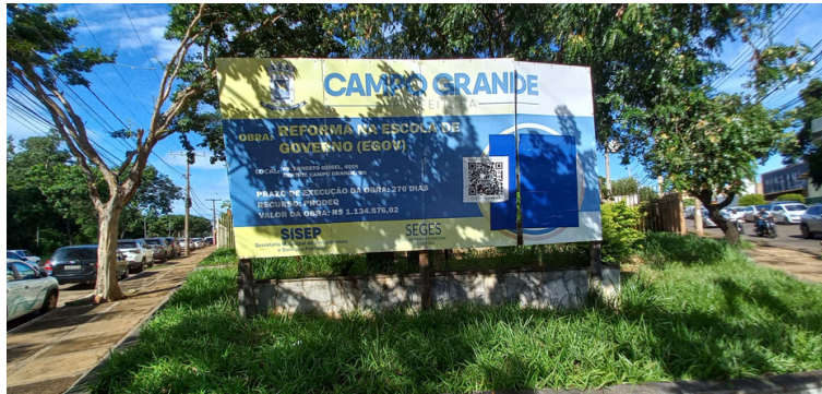
Foto 3 - Placa de sinalização da obra de reforma.
