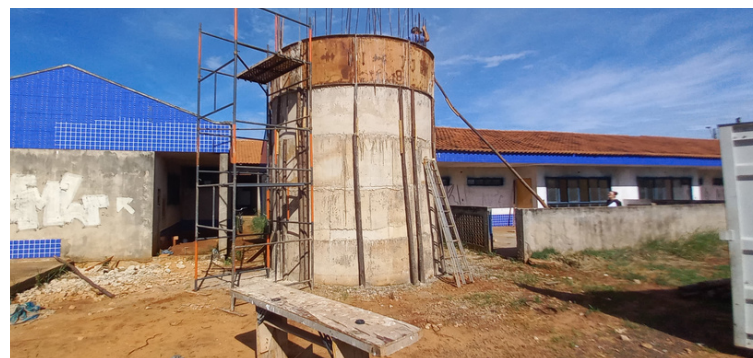
Foto 8 - Construção da caixa d'água da unidade.
