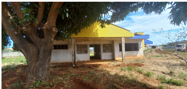
Foto 1 - Edificação da EMEI Jardim Oliveira III.
