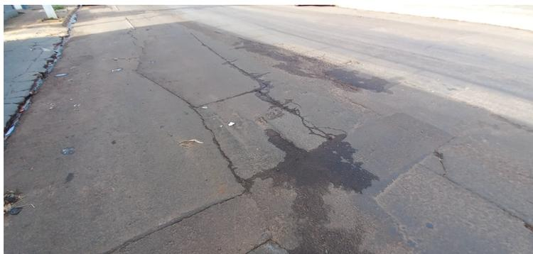
Foto 2 - Recapeamento não realizado por toda a extensão do local, objeto da obra.
