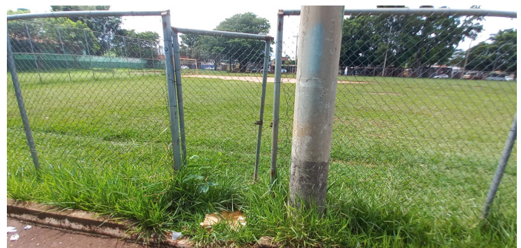
Foto 8 - Campo de futebol com portão deteriorado.
