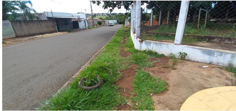
Foto 4 - Pista de caminhada com pavimento desgastado e desníveis.
