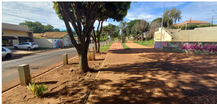
Foto 3 - Não há piso tátil em toda a extensão do parque.
