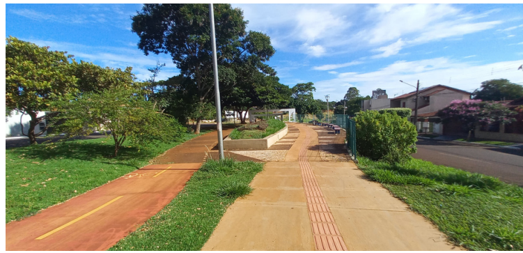
Foto 2 - Pontos que o piso tátil já foi implantado.
