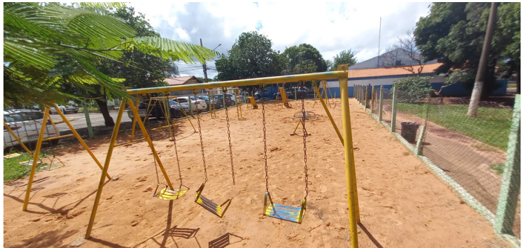
Foto 6 - Parque infantil com brinquedos danificados.
