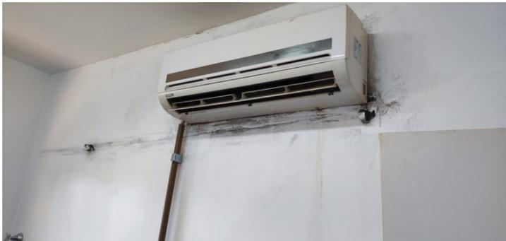
Foto 5 - Gambiarra realizada no Ar-Condicionado em uma das salas de atendimento.
