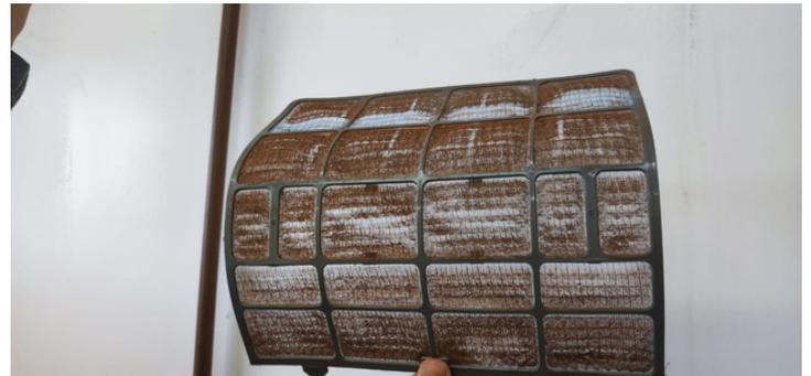
Foto 6 - Filtro do aparelho de Ar-condicionado sem limpeza.
