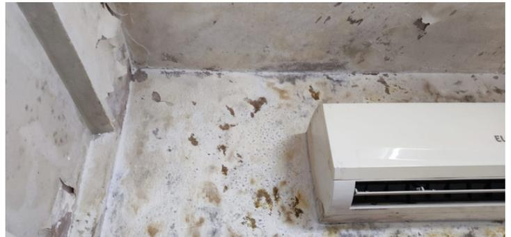
Foto 14 - Mofo e infiltrações em uma das salas de atendimento.
