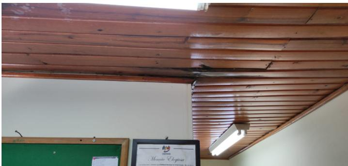
Foto 15 - Forro do teto com vazamento, caindo água no ponto dos servidores.
