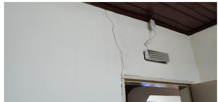
Foto 8 - Rachadura nas paredes da unidade.
