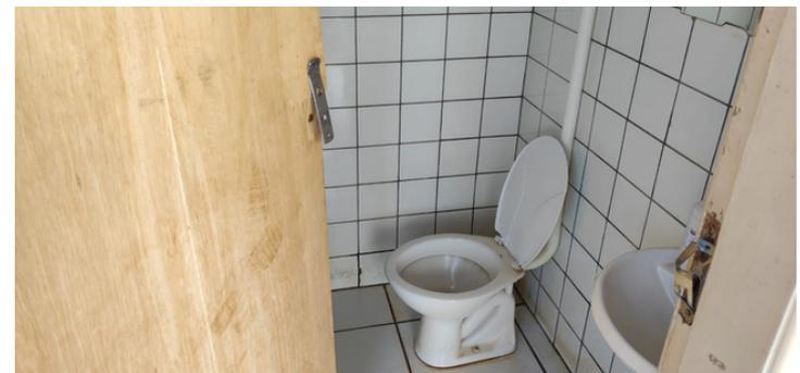
Foto 16 - Porta do banheiro com maçaneta e fechadura quebrados.
