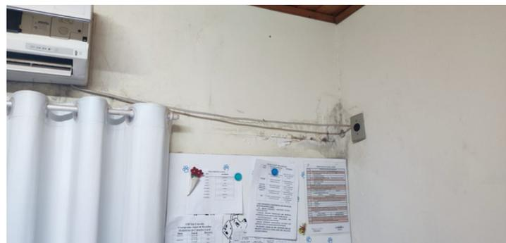
Foto 7 - Sala de atendimento tomada por infiltrações.
