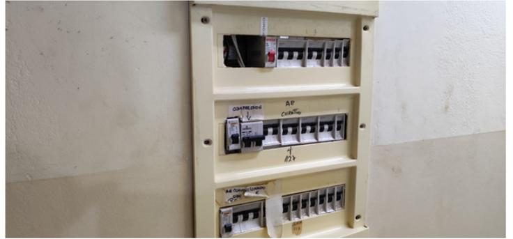
Foto 12 - Caixa de fusível sem proteção.
