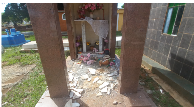
Foto 5 - Jazigos sendo constantemente vandalizados.
