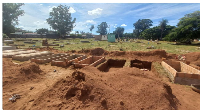
Foto 2 - Construção de gavetas sociais.
