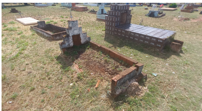
Foto 3 - Determinados túmulos consideravelmente deteriorados.
