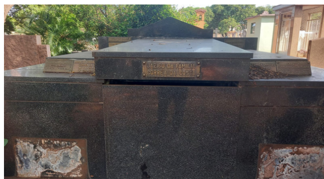
Foto 6 - Sepulturas sendo vandalizadas e tendo seus acessórios furtados.
