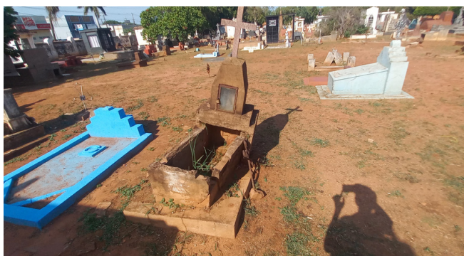
Foto 5 - Determinados túmulos consideravelmente deteriorados.
