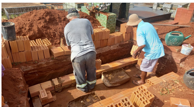
Foto 3 - Sepulturas sendo readequadas conforme a legislação.
